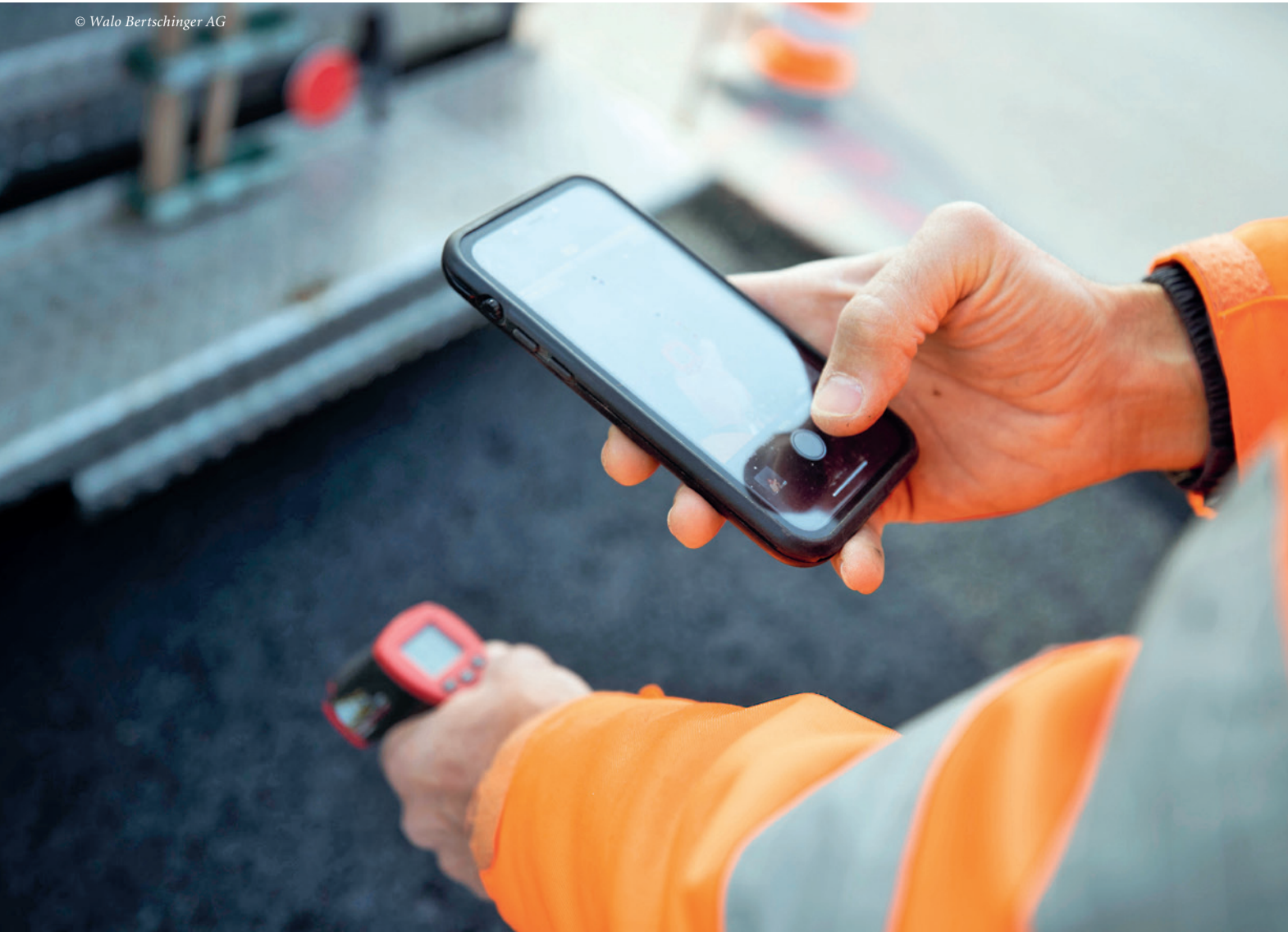
Händisch durchgeführte Zusatzkontrolle der Einbautemperatur hinter dem Einbaufertiger neben den flächendeckenden Messungen (Q-Point)
